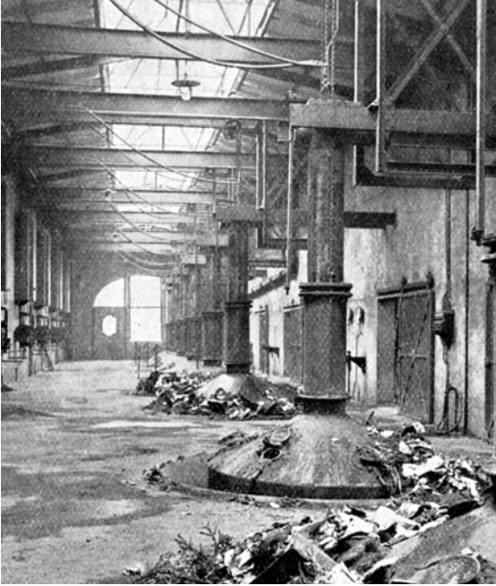
Alter Teichweg: Ofenhalle mit Einfüllöffnungen für die zwölf Öfen
