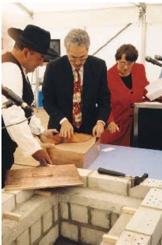
Grundsteinlegung Müllverbrennungsanlage Rugenberger Damm am 12. September 1996 durch Umweltsenator Dr. Fritz Vahrenholt. Die MVA wird 1999 als eine der modernsten und umweltfreundlichsten Anlagen Europas in Betrieb gehen.
