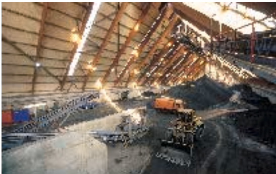
Schlackenaufbereitungshalle der Anlage an der Borsigstraße.
