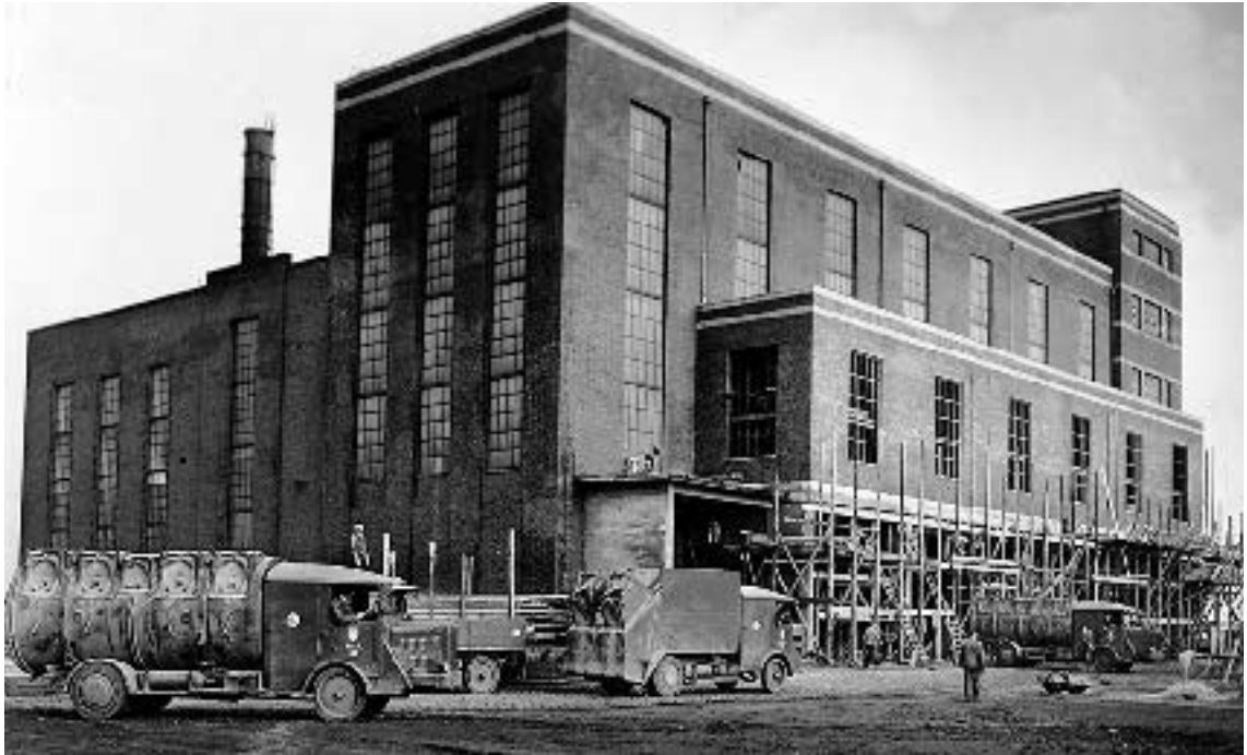
Umbauarbeiten an der Abkipphalle der MVA Borsigstraße
