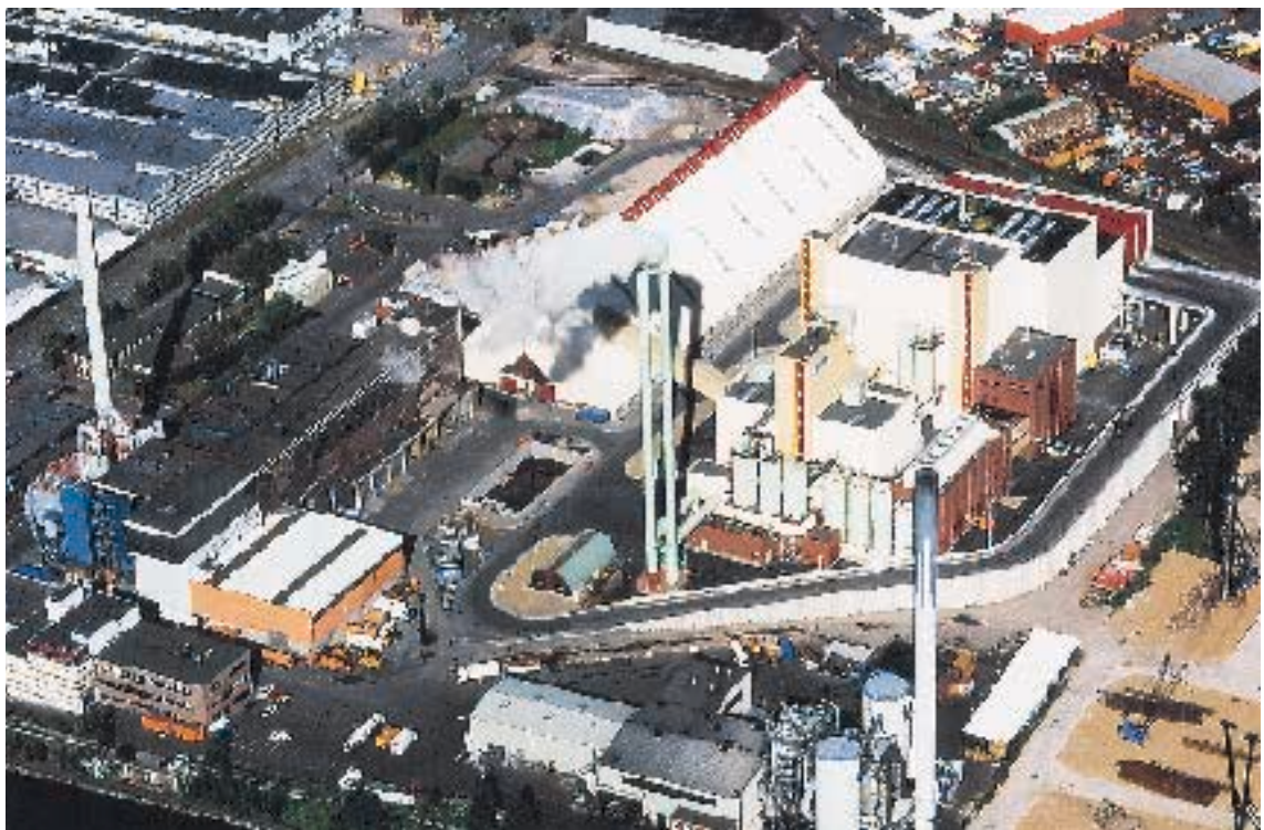
1994 entstand die moderne Müllverwertungsanlage an der Borsigstraße.
