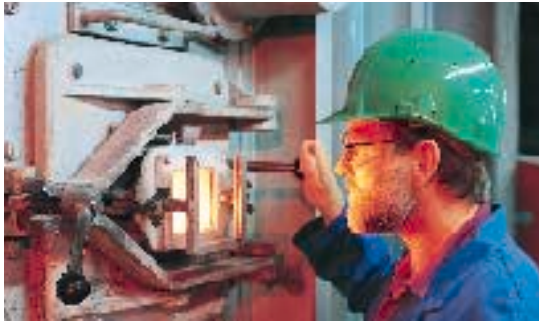
Kontroll-Luke am Verbrennungssofen
