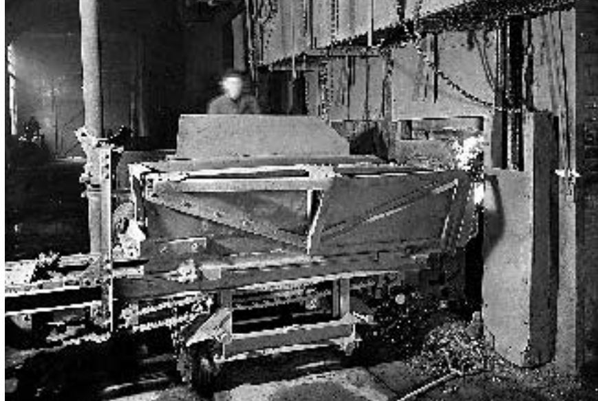
Ruhrstraße: Die Ofenentschlackung war zum Teil mechanisiert.
