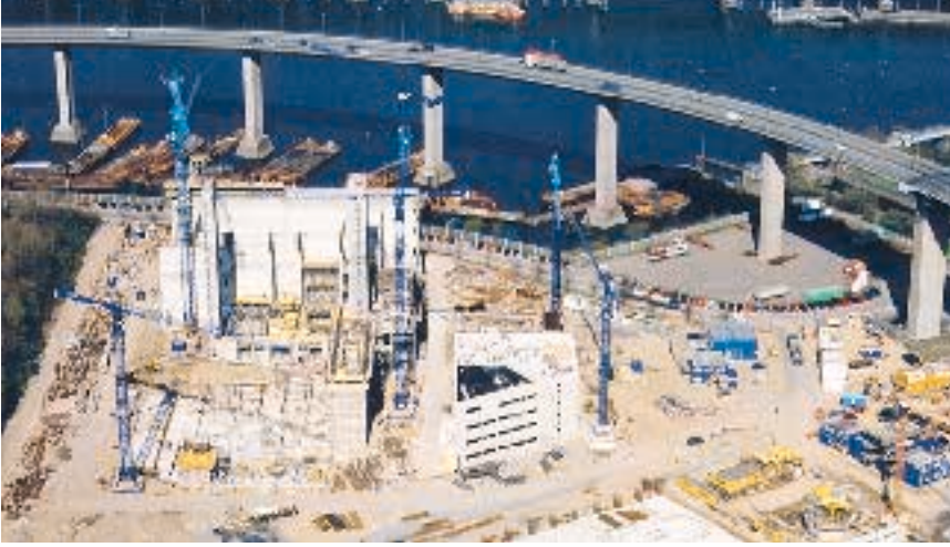
Am Fuße der Köhlbrandbrücke wird die MVR 1999 in Betrieb gehen.
