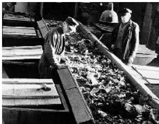
Mit Hilfe eines Sortierbandes wurden die schlecht zu verbrennenden Abfälle aussortiert.
