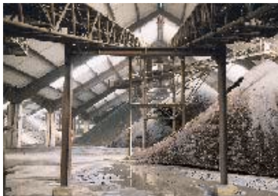
Schlackenaufbereitungshalle in Stapelfeld
